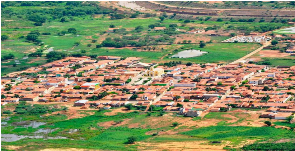
Figura 1 – Centro de Penaforte-CE ao lado da transposição.
