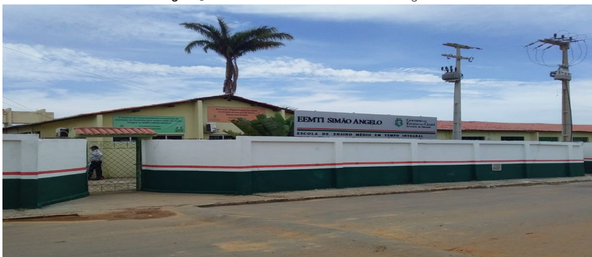
Figura 3 – Fachada da escola estadual Simão Ângelo.
